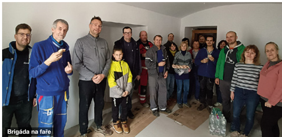
Oprava bytu kněze
